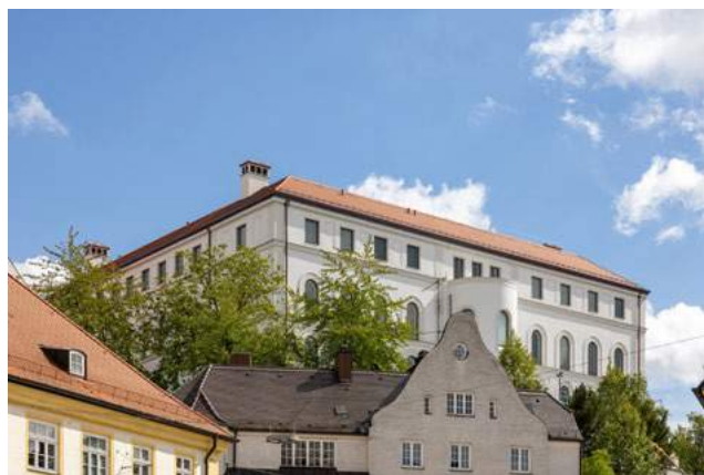
▲ Das Diözesanmuseum Freising von der Oberen Altstadt aus gesehen. Das Gebäude wurde 1868 bis 1870 errichtet und diente rund ein Jahrhundert lang als erzbischöfliches Knabenseminar. 1974 wurde hier das Diözesanmuseum eröffnet. Nach einer mehrjährigen Generalsanierung wurde 2022 das neue DIMU wiedereröffnet.
